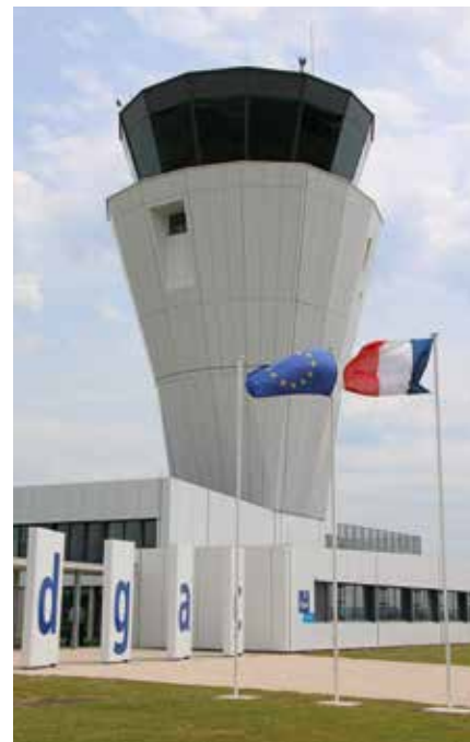
Tour de contrôle de l'aéroport de Beauvais-Tillé mise en service le 22 janvier 2019. Haute de 30 mètres, cette nouvelle tour abrite une vigie de 85 m 2 pouvant héberger jusqu'à six positions de contrôle et une position Chef de tour. L'investissement, financé par la DSNA au travers des redevances payées par les compagnies aériennes, a été de 6 M€ pour le génie civil et de 2,5 M€ pour les équipements techniques.
