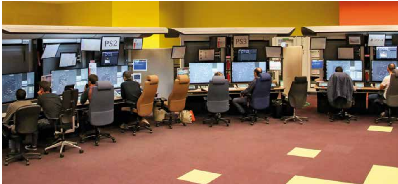
CRNA Ouest : les travaux de réaménagement de la salle de contrôle (intégrant les partenaires du ministère des Armées) et de la salle de formation sur simulateur avec de nouveaux équipements se sont achevés en 2019. Ce projet initié en 2016 a mobilisé 200 personnes. Il a nécessité l'acquisition de 102 meubles pour les positions de contrôle, 100 écrans de contrôle de 43" et la pose de 180 km de câbles.
