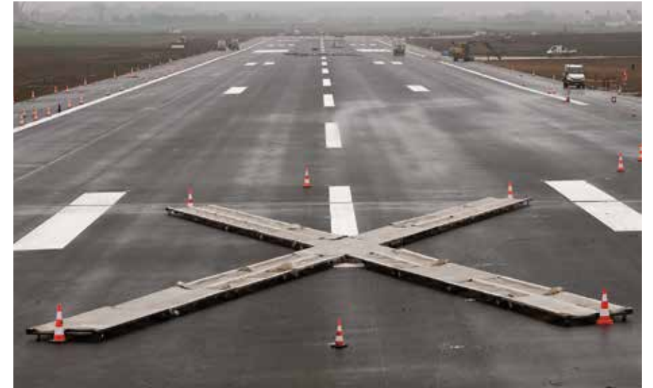
Paris-Orly : fermeture de la piste Sud pendant quatre mois pour reconstruction impactant fortement la gestion de la circulation aérienne.
