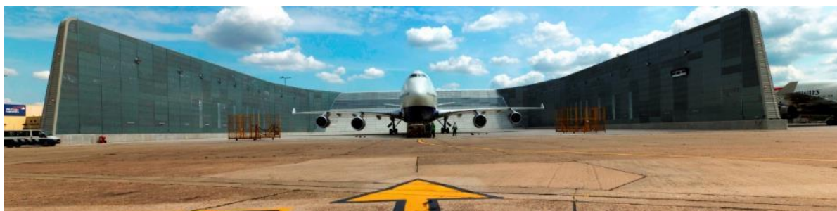
Figure 14 : Murs anti-bruit pour la réalisation des essais moteurs au sol, sur l'aéroport d'Heathrow Source : (iac acoustics, 2013)
