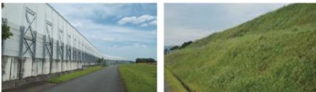
Figure 13 : En haut : principe de fonctionnement d'un écran acoustique. En bas : mur (à gauche) et merlon végétalisé (à droite) anti-bruit autour d'aéroports japonais Source : (Kansai Airports Technical Department, 2019)
